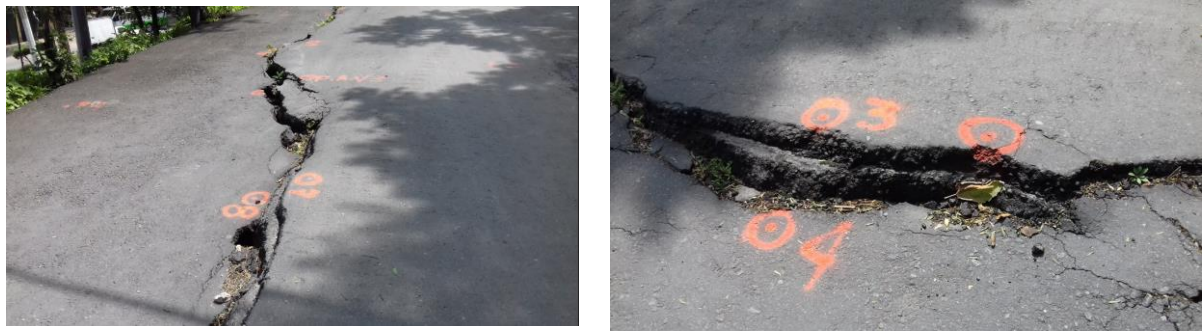
Imagen 13 Evidencias del control topográfico a todo lo largo de la Carretera Xochimilco-Tulyehualco. Fuente: Comisión para la Reconstrucción.
