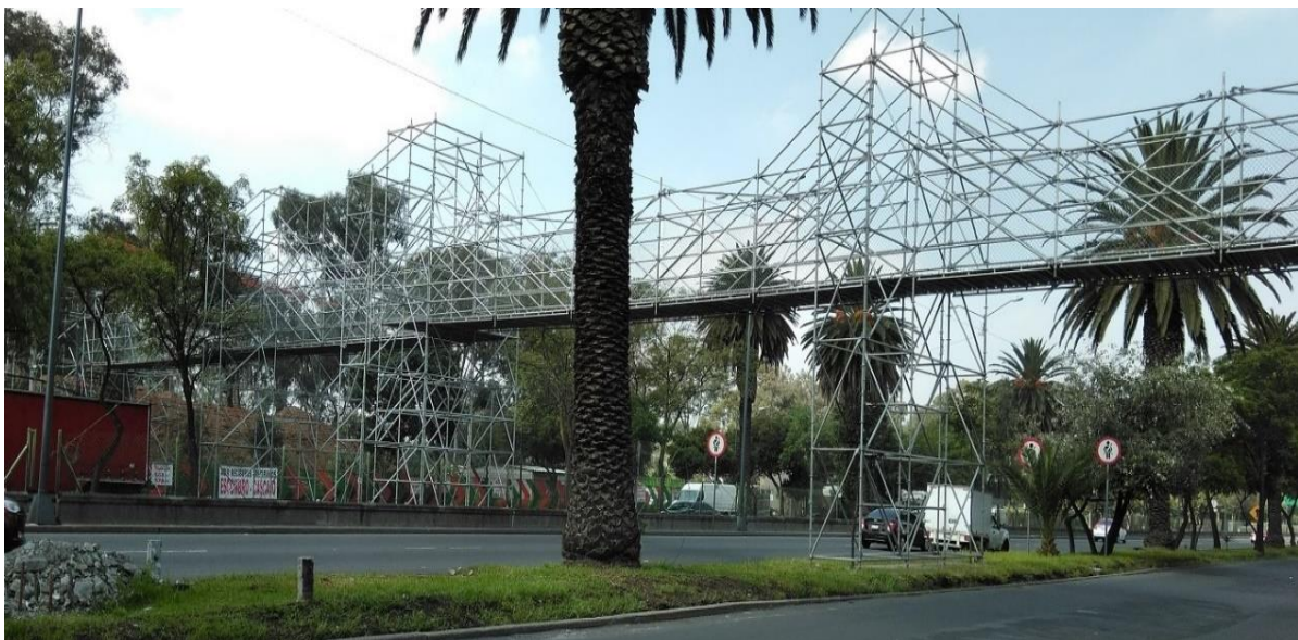
Imagen 14 Puente provisional 1 Anillo Periférico y calle Cañaverales.
