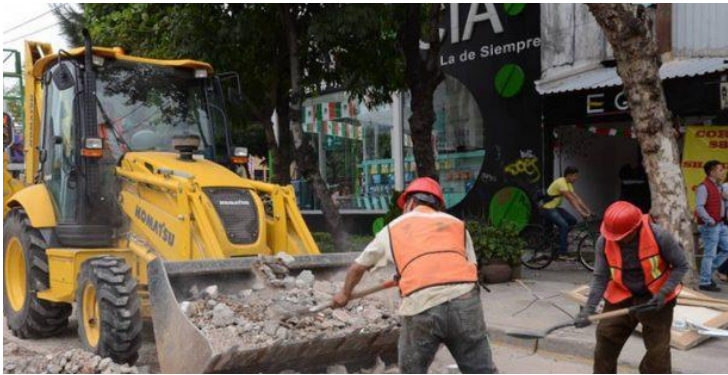
Ilustración 6 Retiro y escombro de demolición
